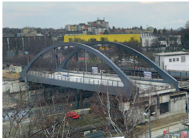
Structure porteuse finale après mise en place.
